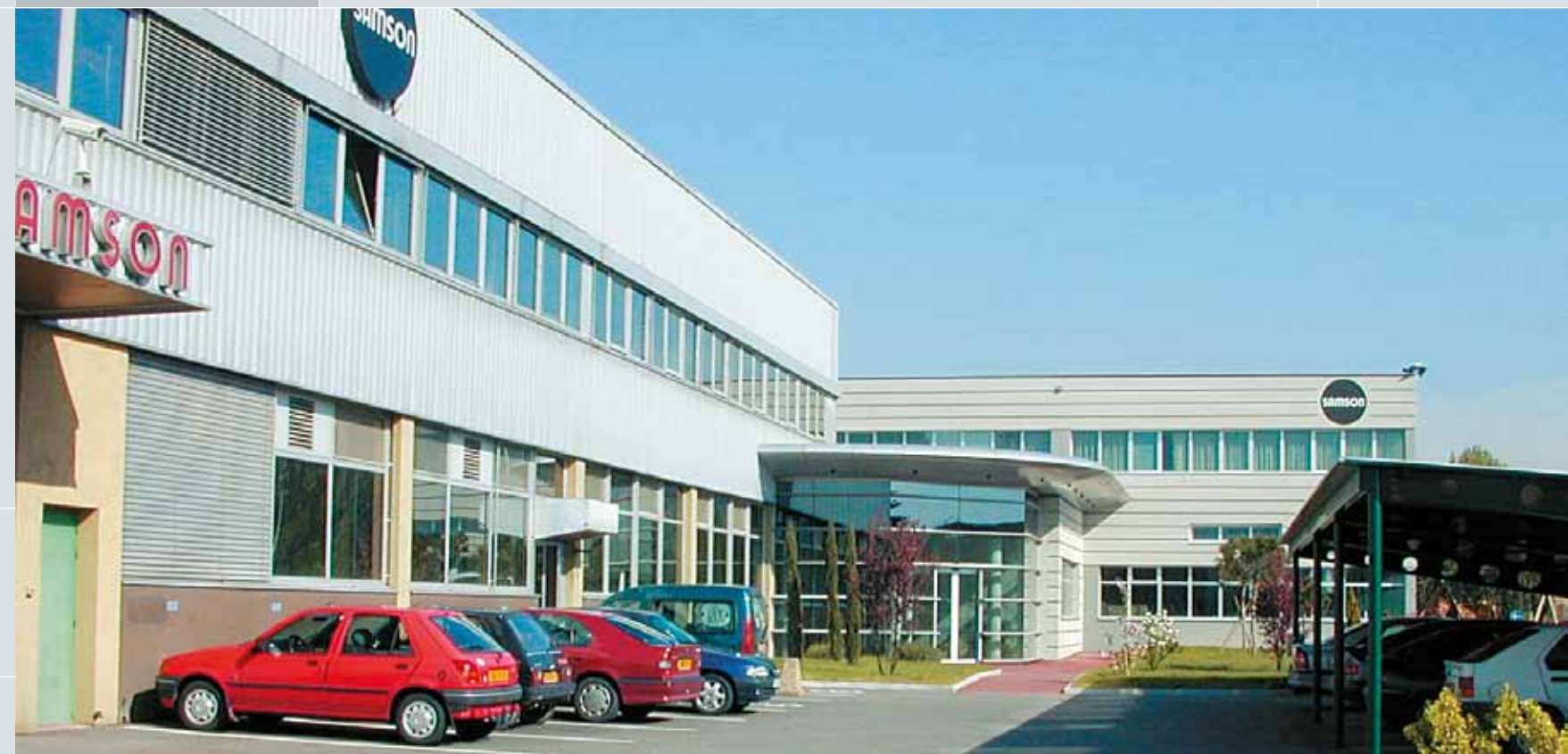
Partie prenante de l'essor industriel de la région Rhône-Alpes: la filiale française de SAMSON AG à Vaulx-en-Velin près de Lyon.
