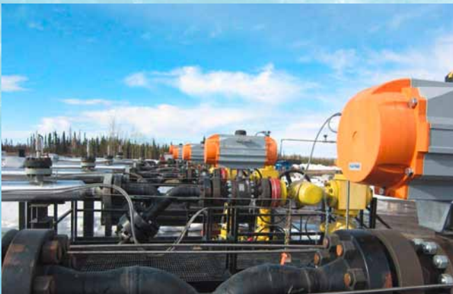
Válvulas de bola STARLINE con accionamiento AIR TORQUE que regulan el flujo de gas desde el origen hasta el gaseoducto, en el río Horn en el norte de Columbia Británica
