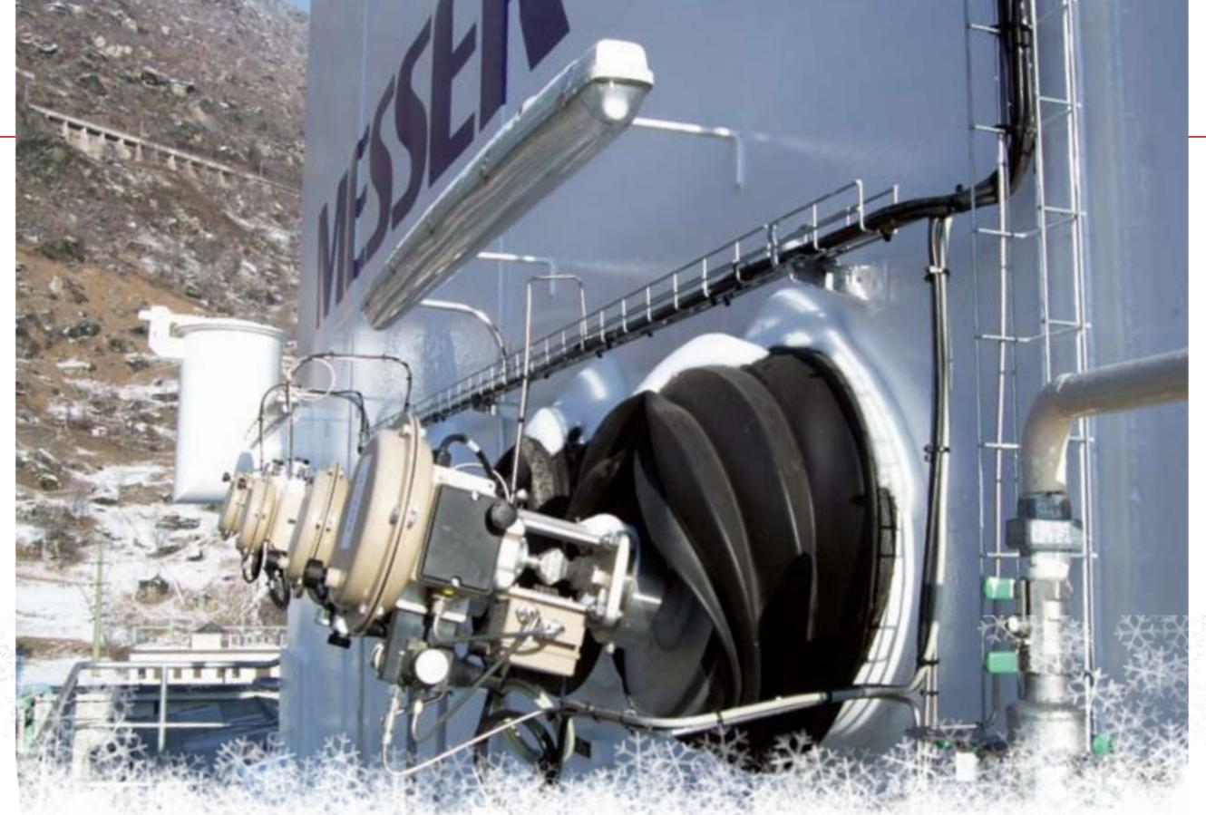
El fuelle de estanqueidad de las válvulas para bajas temperaturas de SAMSON mantienen el frío dentro de la cold box y evitan la congelación de las partes externas.
