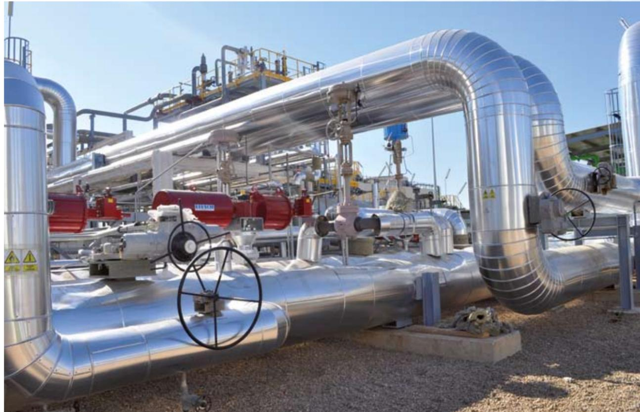
En la planta SAMCASOL una válvula de mariposa LEUSCH LTR 43 y una válvula de globo SAMSON Tipo 3241 funcionando en split-range se encargan de controlar el caudal y la temperatura del aceite térmico que circula por todo el campo solar hasta la central eléctrica.
