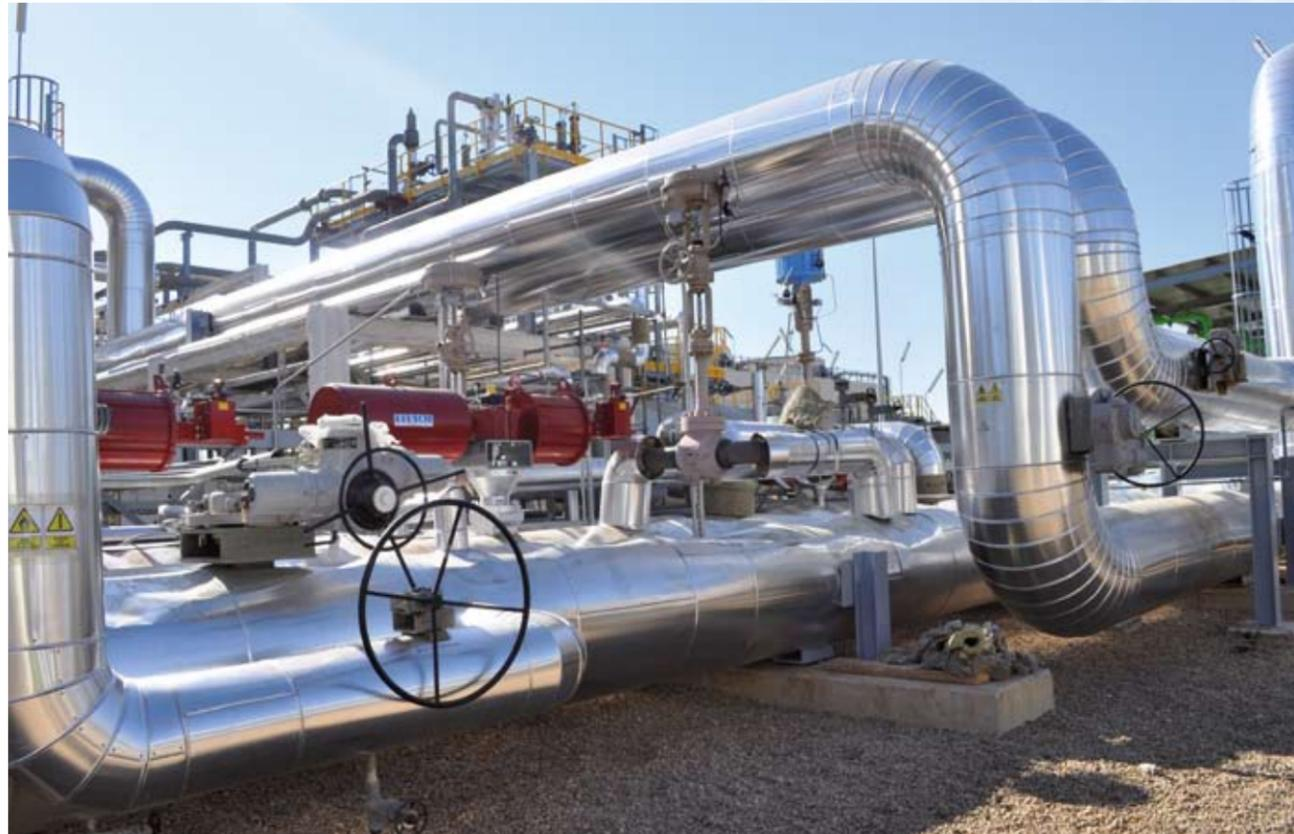
Bei SAMCASOL werden Durchfluss und Temperatur des Wärmeträgeröls, das aus dem gesamten Solarfeld zum Kraftwerk geführt wird, mit einer Klappe LTR 43 von LEUSCH und einem Ventil Typ 3241 von SAMSON im Split-Range-Verfahren geregelt.
