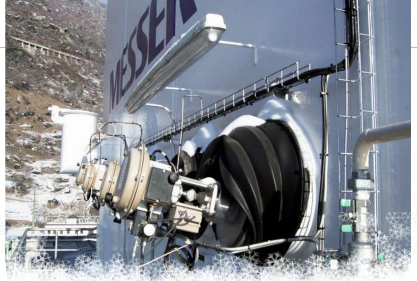
Die tief liegende Balgabdichtung der Tieftemperaturventile von SAMSON hält die Kälte in der Cold Box und verhindert zuverlässig die Vereisung der äußeren Teile.
