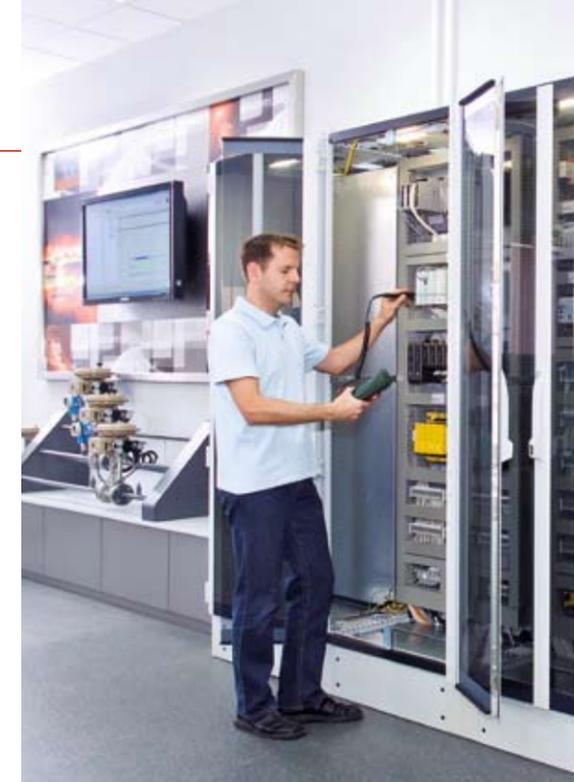
Die Feldkomponenten können im SVIC in Leitsysteme eingebunden werden. Zugleich ist aber auch der dezentrale Abruf azyklischer Diagnoseinformationen möglich.
