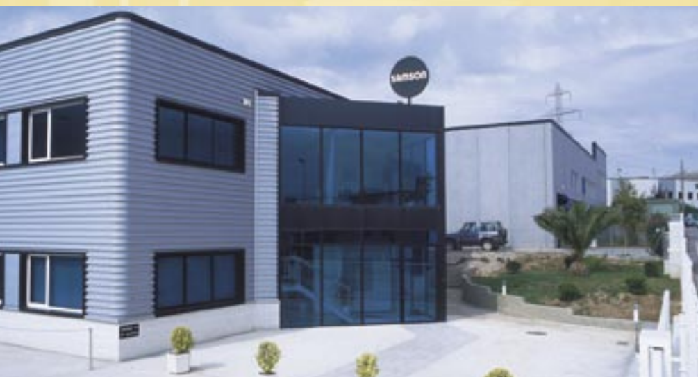
Kaum acht Jahre alt, benötigt der Firmensitz von SAMSON S.A. in Rubí bei Barcelona schon einen Erweiterungsbau.
