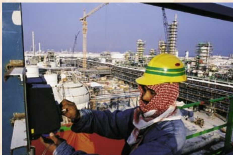
Gran parte del fatturato di SAMSON è attribuibile all'export, che viene maggiormente coordinato dalle filiali locali.
