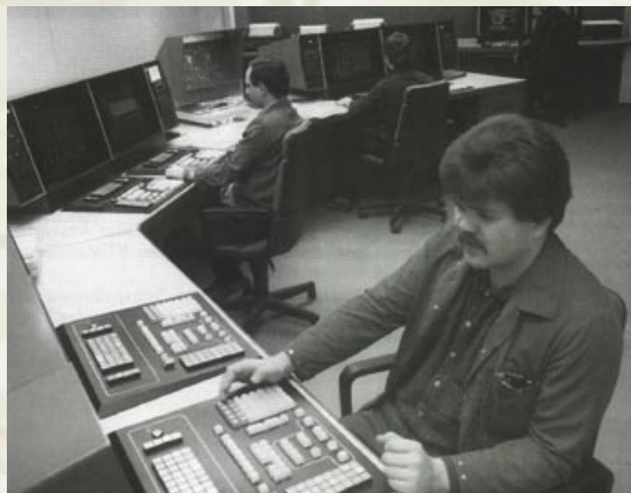
Operatori nella sala di controllo del sistema di monitoraggio del processo intorno al 1975. Monitor e tastiere hanno sostituito la vecchia strumentazione.
