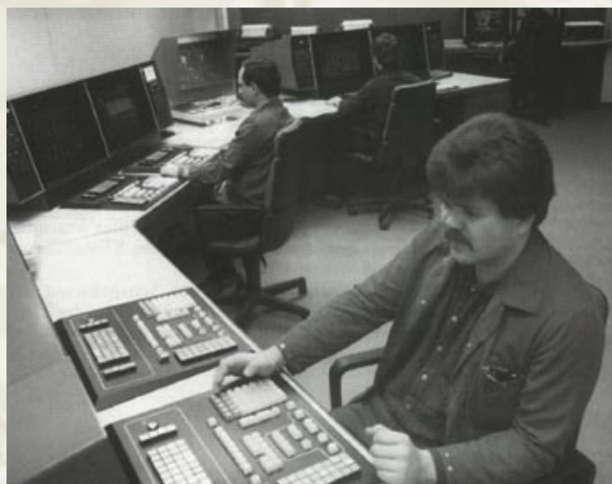
Poste de contrôle avec système de régulation des procédés vers 1975. Ecrans et claviers ont remplacé les grandes façades équipées d'instruments de mesure.
