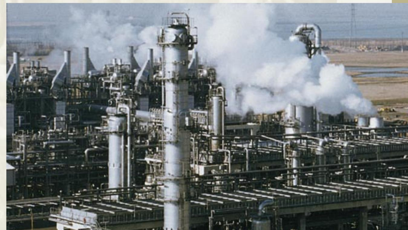
Plus de 1000 vannes de réglage sont installées sur l'un des plus grands vapocraqueurs du monde à Anvers, à des températures de fluide allant de -200 °C à +500 °C.
