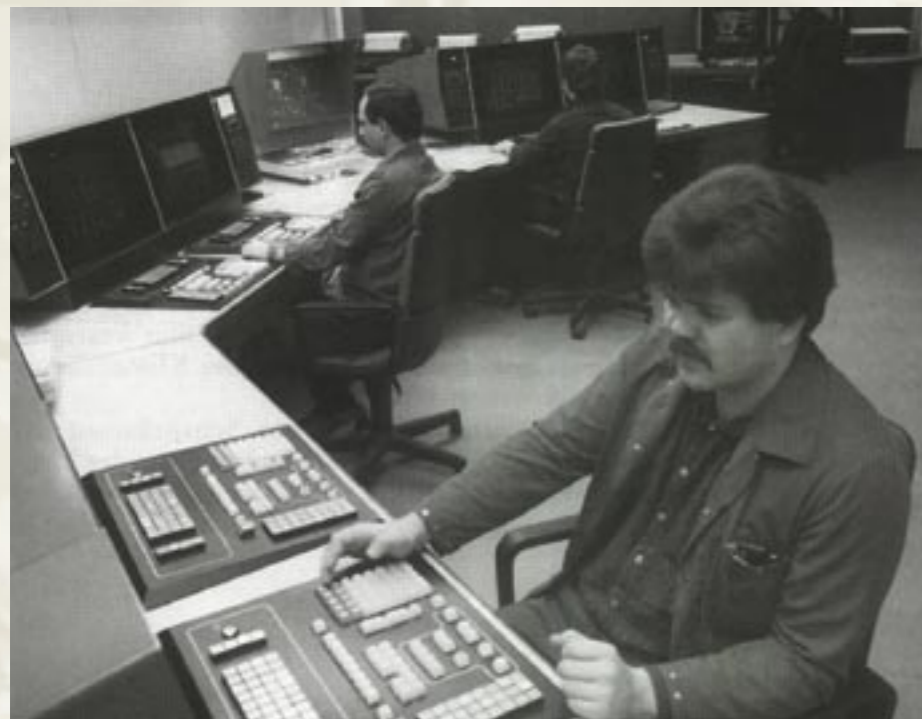
Arbeitsplätze in einer Messwarte um 1975 mit Prozessleitsystem. An die Stelle der langen Messwände waren Pulte mit Bildschirmen und Tastaturen getreten.
