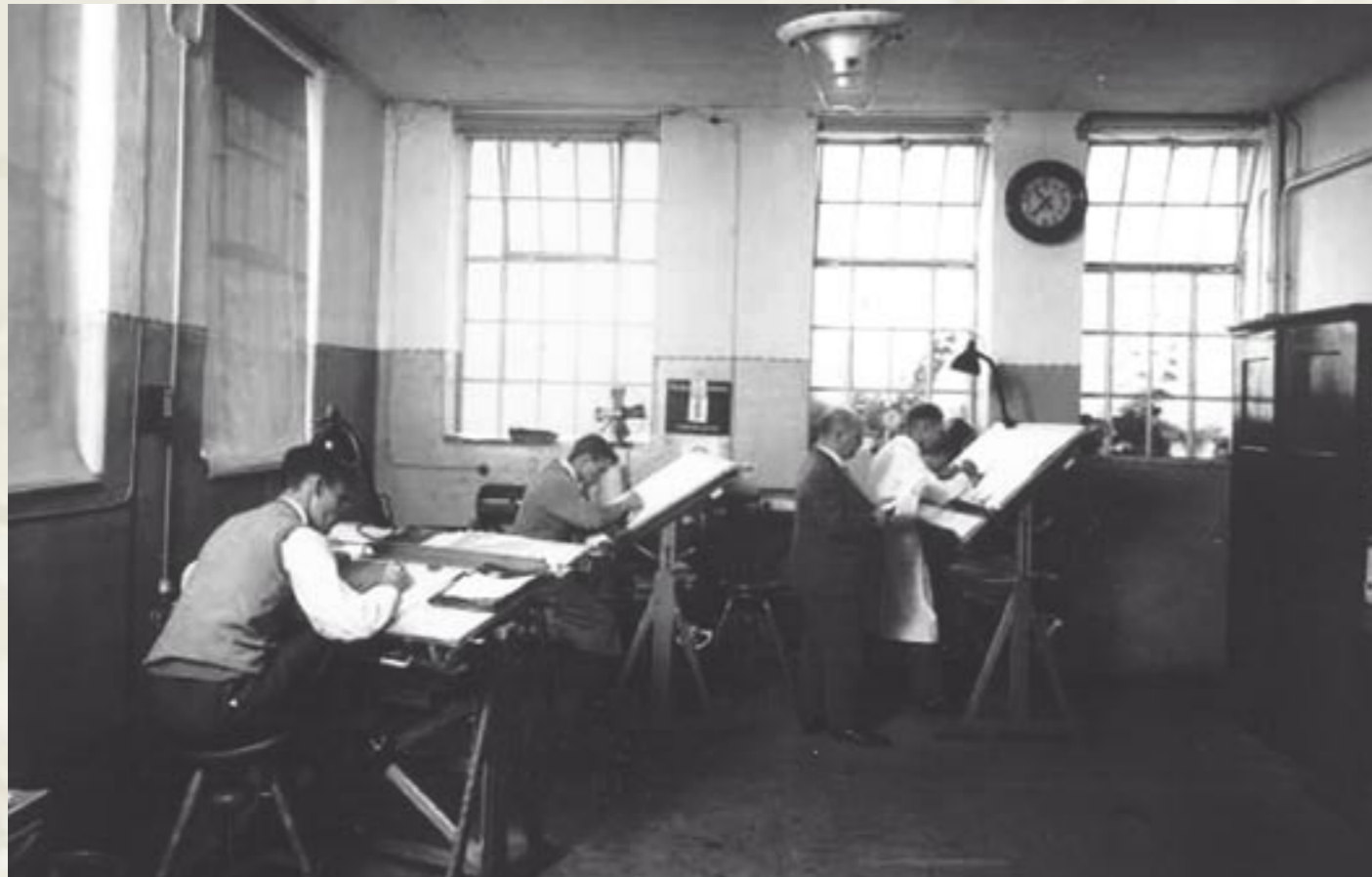
Auf einfachen Reißbrettern wurden die ersten SAMSON-Apparate konstruiert. Zum Handwerkszeug der Ingenieure gehörten noch der Rechenschieber, die Logarithmentabellen und die Dampfzettel.
