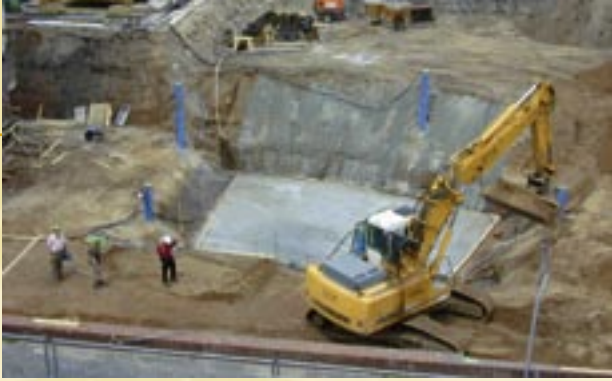
Inizio dei lavori il 17. maggio 2005; il nuovo edificio comprende un volume complessivo di oltre 21.000 m 3 .
