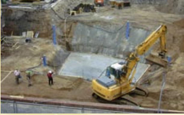
Inicio de la construcción del edificio el 17 de Mayo de 2005: el nuevo edificio tiene un volumen bruto de 21.000 metros cúbicos.
