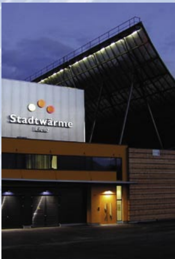
Nel 2001 Lienz ha costruito un impianto di riscaldamento a biomassa. SAMSON ha fornito la regolazione per 1000 staz. di teleriscaldamento.
