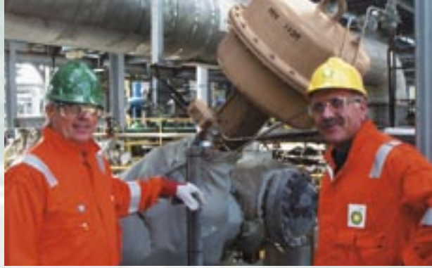
M. Hans Grimm (à droite) et M. Glyn Butler (à gauche) chez BP Hull devant une vanne SAMSON en cours d'installation.
