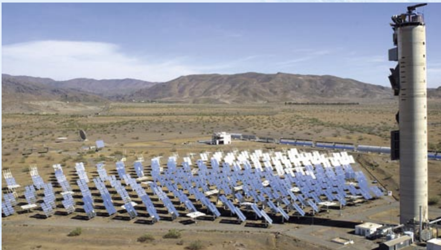
300 specchi seguono il percorso del sole in Andalusia e riflettono la sua luce sulla torre, CESA-1, per produrre vapore da utilizzare per generare elettricità.
