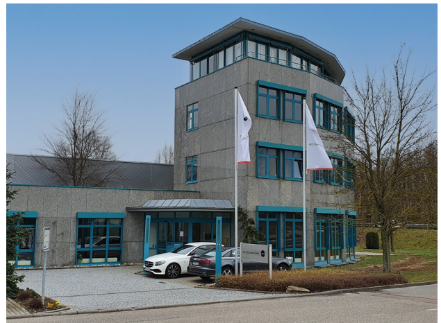
Das Bürogebäude ist mit dem Produktionsgebäude verbunden woraus sich wesentliche Vorteile für die Kommunikation und die interne Logistik ergeben
