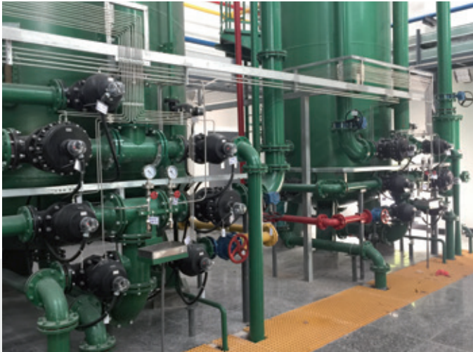
Heißwassersystem in Kohlekraftwerken
